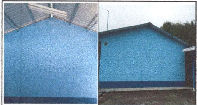
Foto 2: Pintura de las paredes aulas internas y externas terminada.
