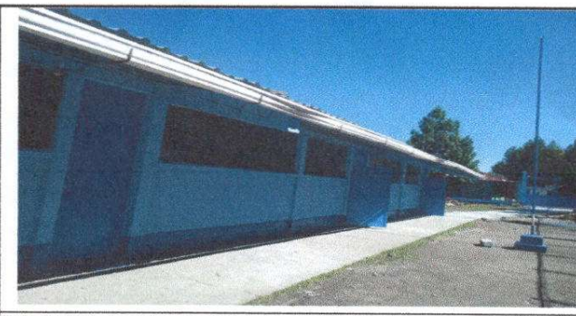
Foto 5: Pintura en puertas y paredes modulo No. 2
