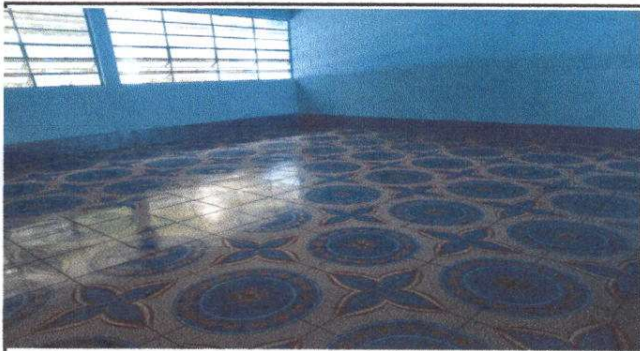
Foto 3: Sustitución de piso por ceramico en aulas.
