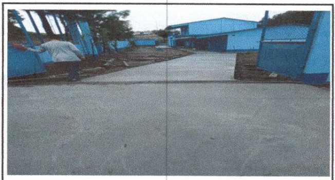
Foto 4: Colocación de torta de concreto area de patio.
