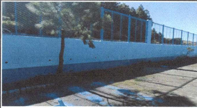
Foto1: Pintura de pared de blok y malla de circulación terminada.
